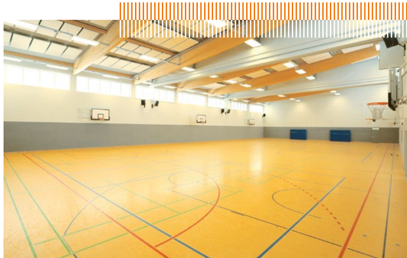
Innenansicht der neuen Sporthalle der RWTH Aachen.
